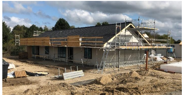
Billede fra byggepladsen
